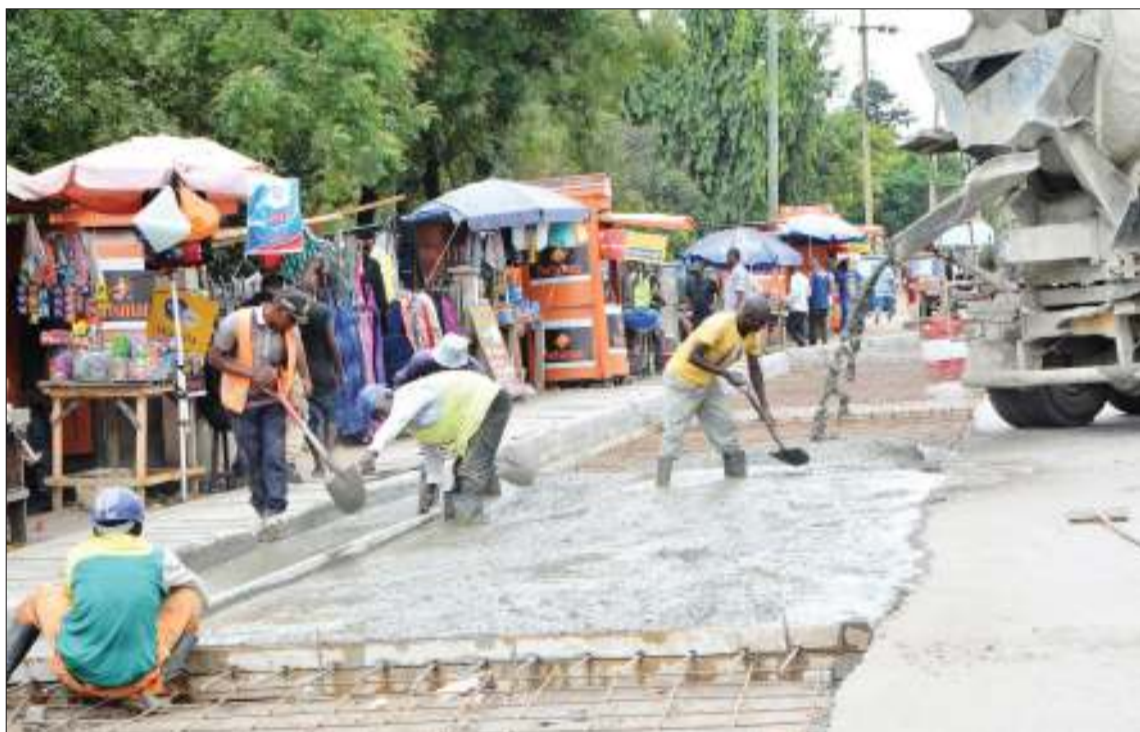
Mafundi wa ujenzi wakien-delea na kazi ya kuweka zege kwenye vituo vya daladala eneo la kituo cha Temeke Hospitali, jijini Dar es Salaam jana. PICHA: MIRAJI MSALA
