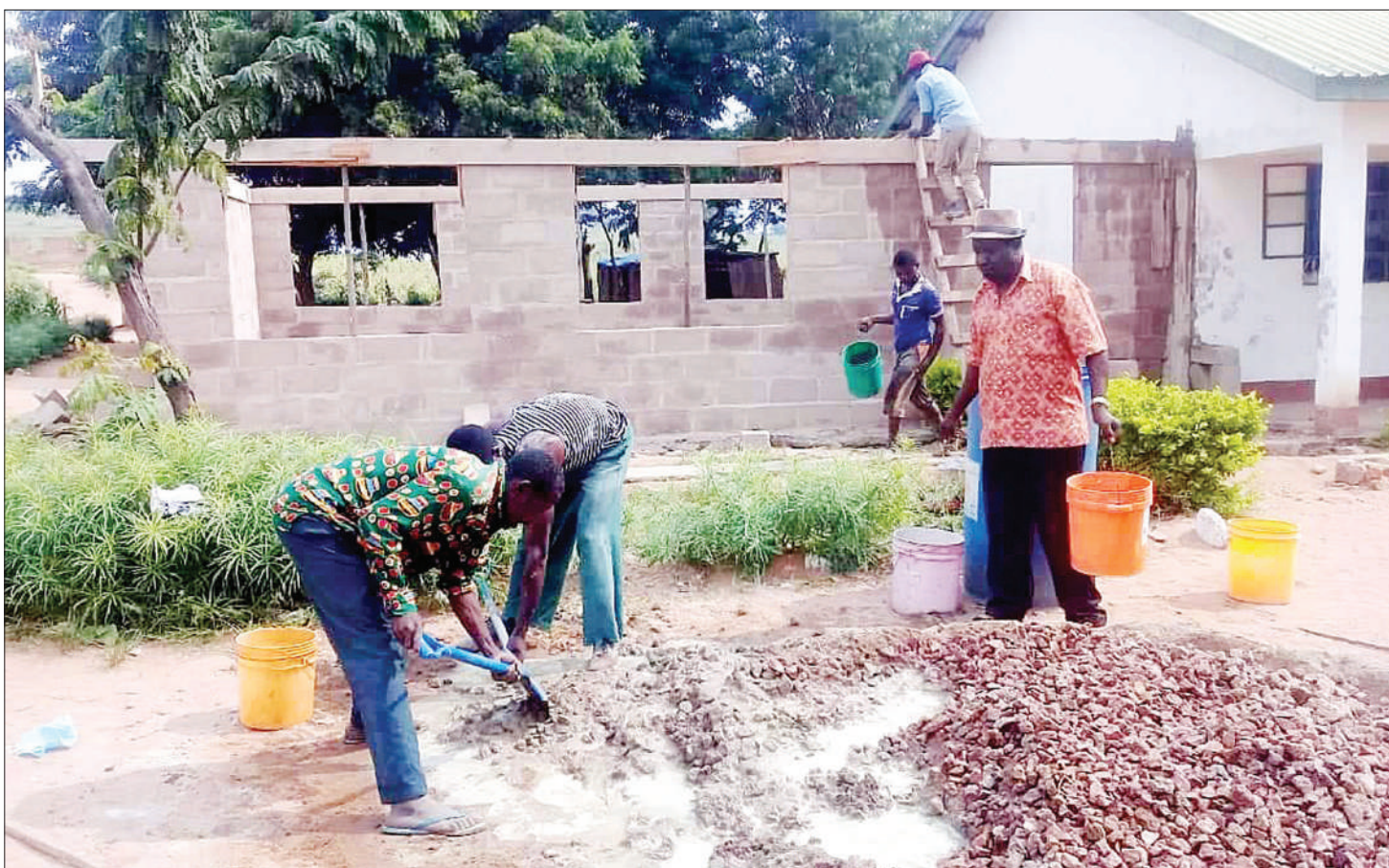
Mafundi wakiendelea na ujenzi wa moja ya madarasa kwa ajili ya wanafunzi wa kidato cha kwanza, katika Shule ya Sekondari ya Kata ya Rusoli, Msumbwa Vijijini, mkoani Mara jana, ambayo mwaka huu imepokea jumla ya wanafunzi 132. Picha: MPIGA Picha Wetu
