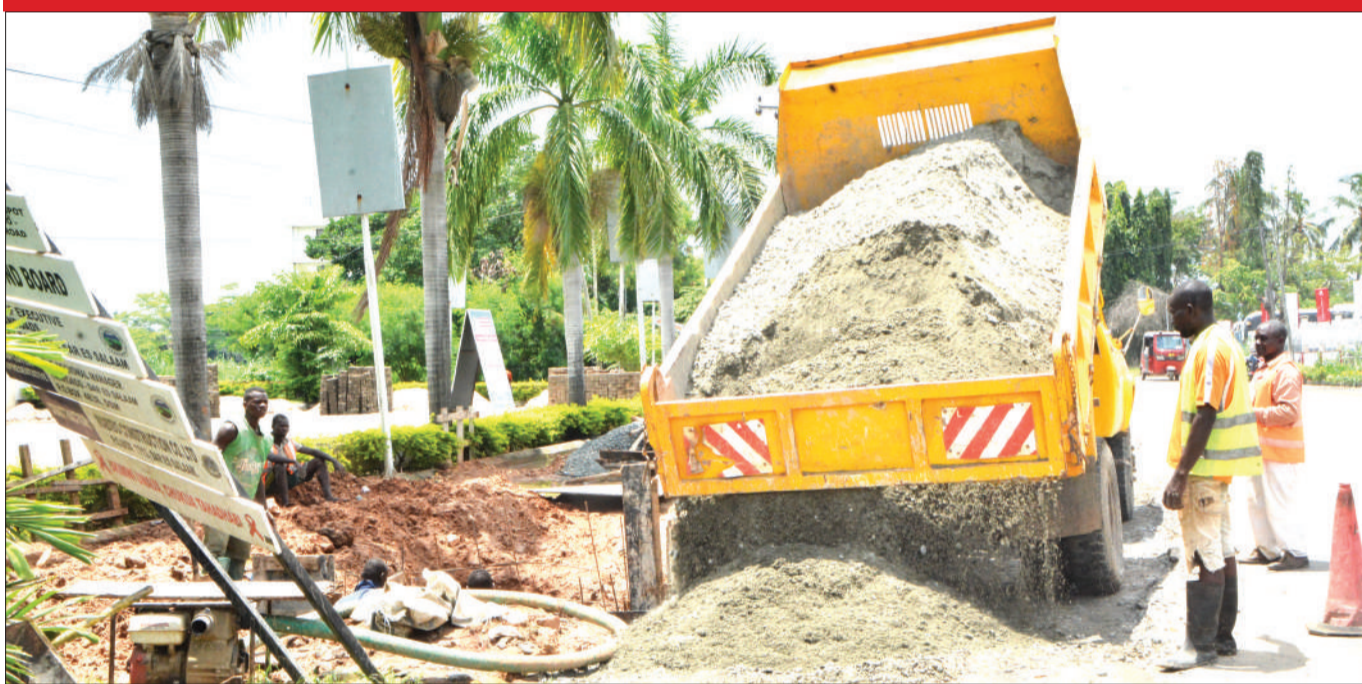
Mafundi wa kampuni ya Mabibo Construction Ltd, wakiendelea na ukarabati wa barabara ya Mwai Kibaki, eneo la Mikocheni Chama, jijini Dar es Salaam jana. PICHA: MIRAJI MSALA
