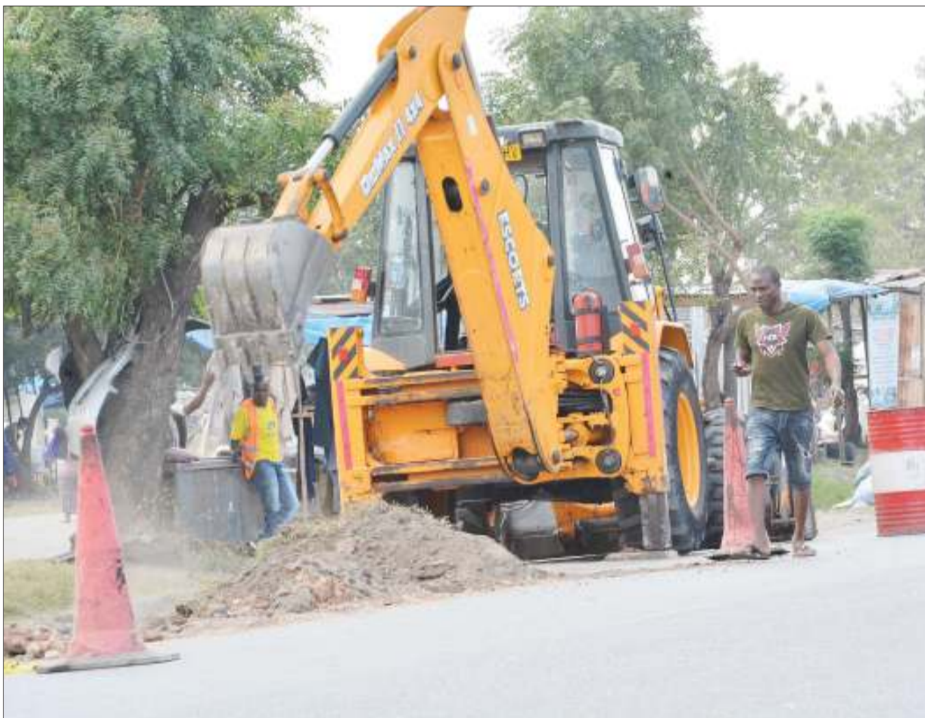
Kijiko kikiondoa mchanga uliokuwa umeziba kwenye mitaro ya maji ya mvua katika eneo la Kawe, jijini Dar es Salaam jana. PICHA: MIRAJI MSALA
