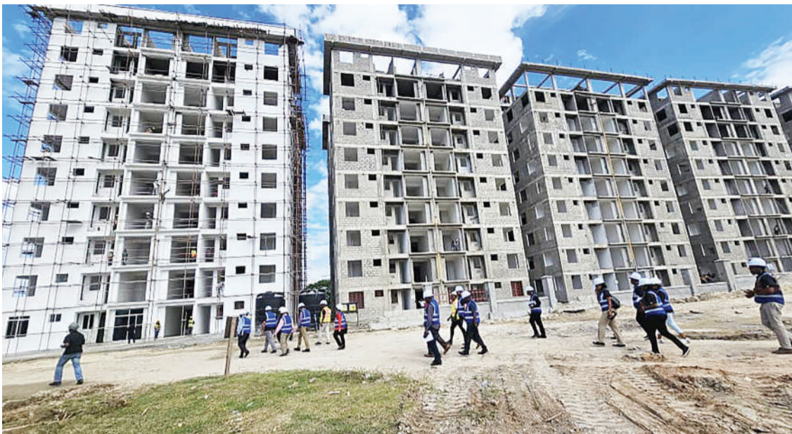
Wajumbe wa Bodi ya Shirika la Nyumba nchini (NHC), wakikagua majengo mbalimbali yanayojengwa na shirika hilo katika mradi wa Samia Housing Scheme Kawe, Manispaa ya Kinondoni, Dar es Salaam juzi. PICHA: JOSEPH MWENDAPOLE
