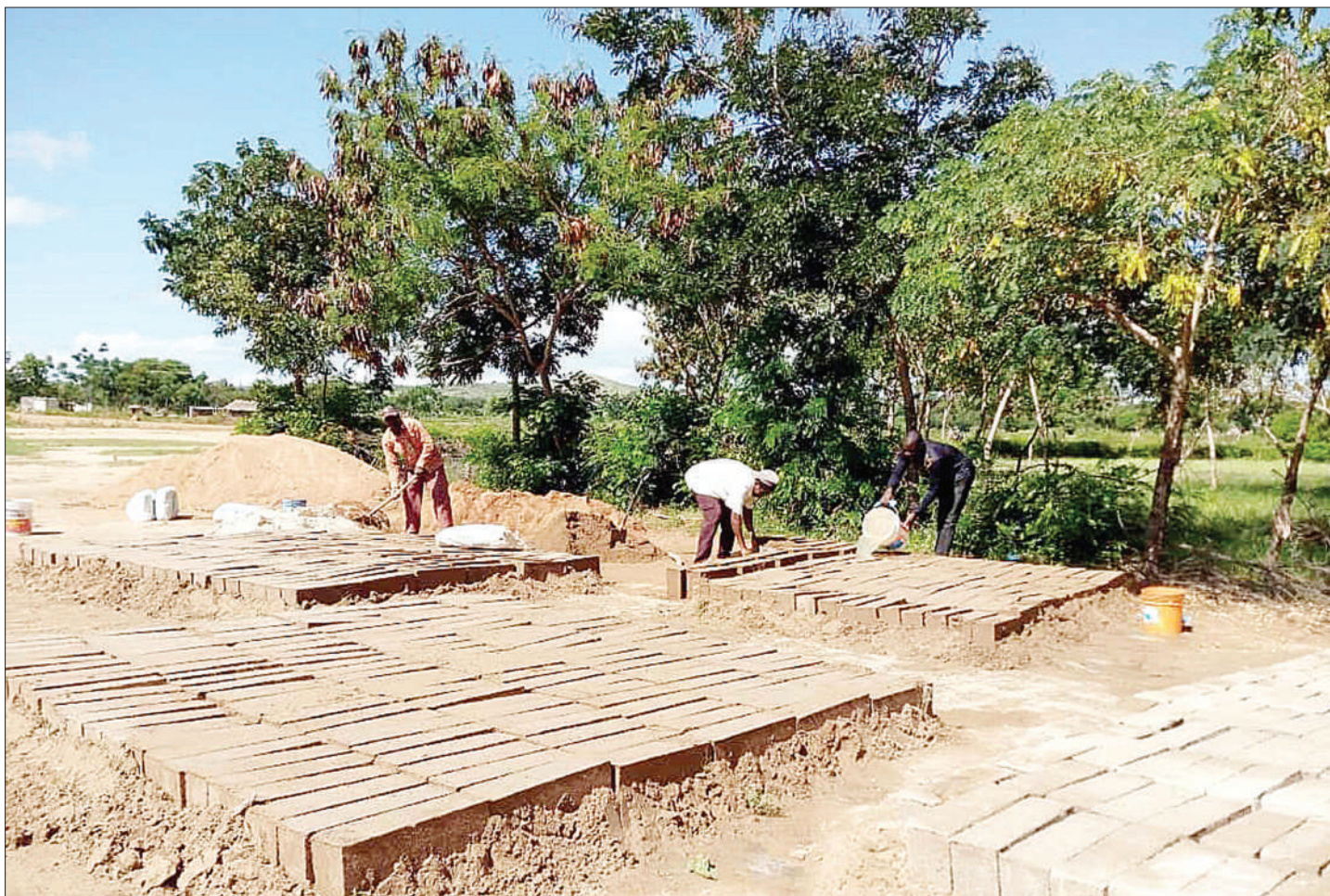
Mafundi wakifyatua matofali kwa ajili ya ujenzi wa madarasa ya Shule ya Msingi Mkapa, iliyopo katika kijiji cha Kastam, Kata ya Bukima Musoma Vijijini mkoani Mara juji, ambayo kwa sasa ina madarasa 10 na yanahitajika mengine 14. PICHA: MPIGA PICHA WETU
