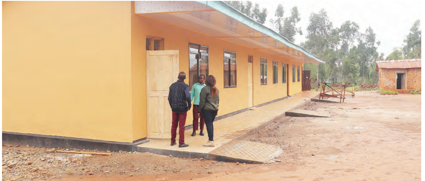
Jengo la madarasa mawili na ofisi ya mwalimu mkuu katika Shule ya Msingi Muganza, lililojengwa kwa ushirikiano wa wananchi, Halmashauri ya Wilaya ya Ngara na Kampuni ya Tembo Nickel, likiwa limekamili. NA MPIGAPICHA WETU
