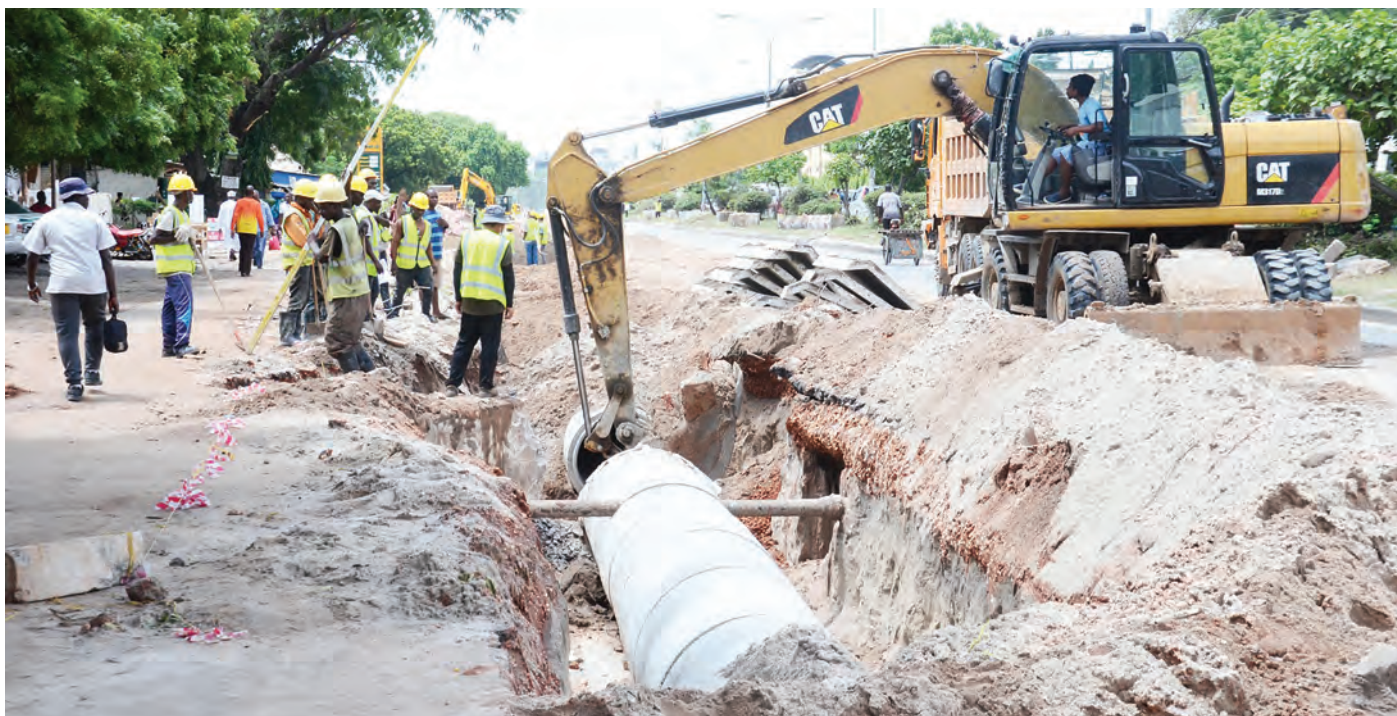
Mafundi wakiweka makaravati kwa ajili ya mifumo ya maji ya mvua kwenye ujenzi unaoendelea wa miundombinu ya mabasi ya mwendo kasi, katika Barabara ya Kawawa, eneo la Kigogo, jijini Dar es Salaam jana. PICHA: JUMANNE JUMA
