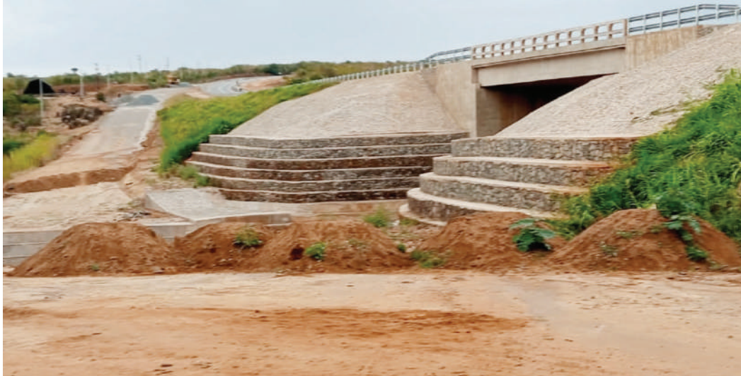
MWonekano wa daraja jipya la Kiyegeya linalounganisha mikoa ya Morogoro na Dodoma lililojengwa na serikali kwa kutumia fedha za matengenezo ya dharura kutoka Mfuko wa Barabara baada ya daraja la zamani kusombwa na mafuriko. PICHA: RFB.
