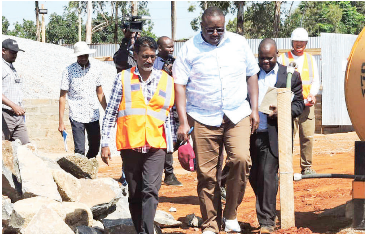
Naibu Katibu Mkuu wa Wizara ya Maji, Mhandisi Cyprian Luhemeja (katikati), akikagua maendeleo ya ujenzi wa chanzo cha maji cha mradi wa maji wa Tarime-Rorya juzi, ambao unajengwa kwenye chanzo cha Ziwa Victoria na kitakuwa na uwezo wa kuzalisha lita milioni 29 za maji kwa siku. PICHA: JOSEPH MWENDAPOLE
