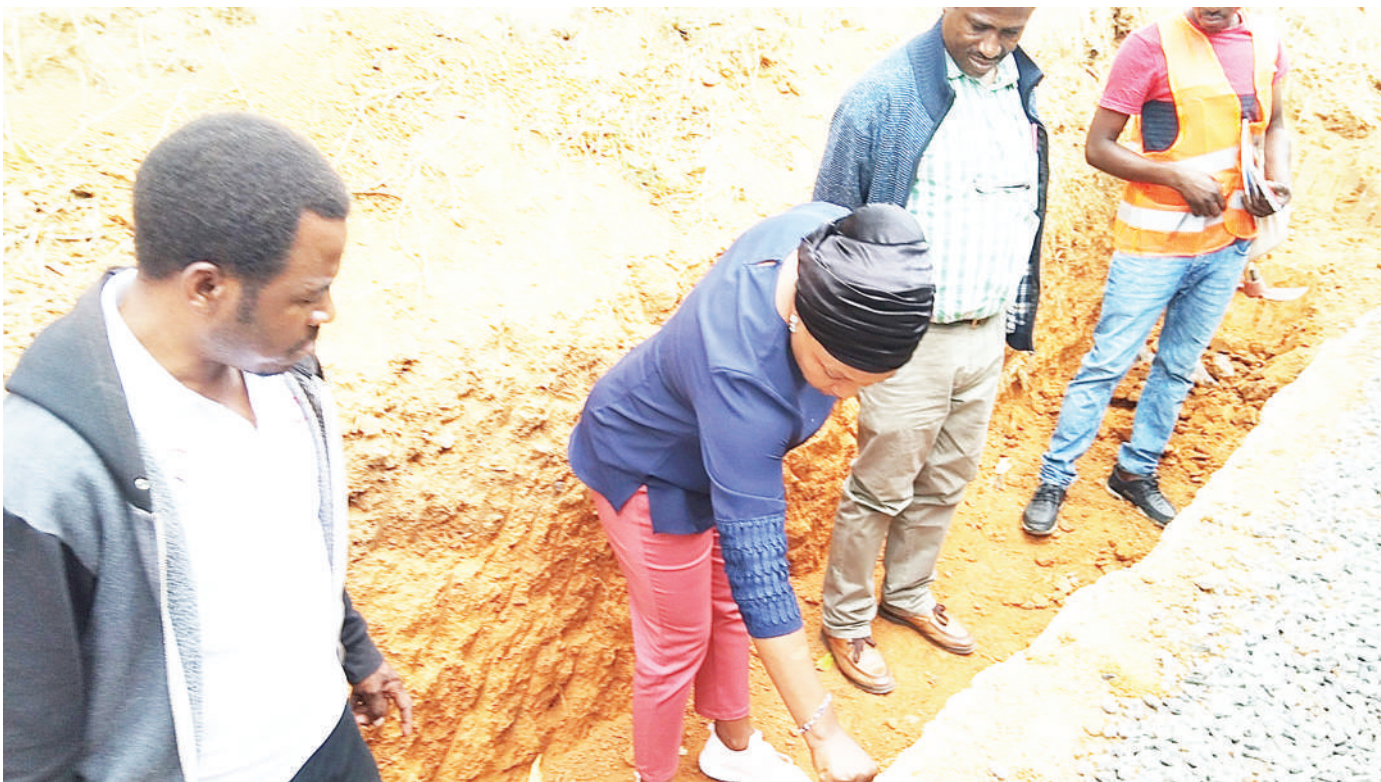
Mkuu wa Mkoa wa Iringa, Queen Sendiga, akikagua ujenzi wa barabara ya Gangilonga inayojengwa kwa kiwango cha lami mjini Iringa juji. PICHA: FRANCIS GODWIN
