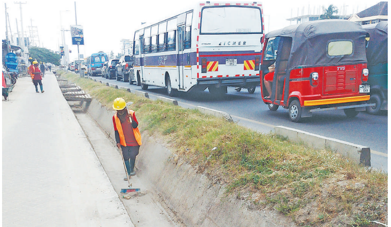
Mfanyausafi akisafisha kuondoa taka katika mfereji wa maji ya mvua, kando ya Barabara ya Bagamoyo, eneo la Mwenge, Dar es Salaam jana. PICHA: JOHN BADI
