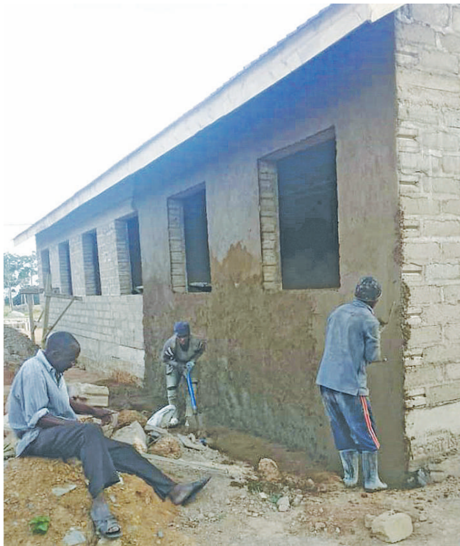
Mafundi wakiendelea na ujenzi wa madarasa ya sekondari mpya ya Kijiji cha Butata, Kata ya Bukima, Musoma Vijijini, mkoani Mara jana. Sekondari hiyo, inatarajiwa kufunguliwa mwezi ujao. PICHA: MPIOGICHA WETU
