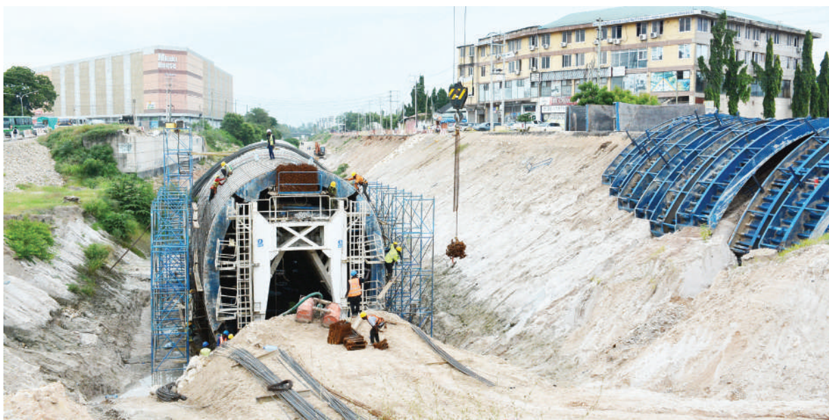
Mafundi wakienenda na ujenzi wa daraja la chini la treni katika eneo la Kamata jijini Dar es Salaam jana. PICHA: MIRAJI MSALA
