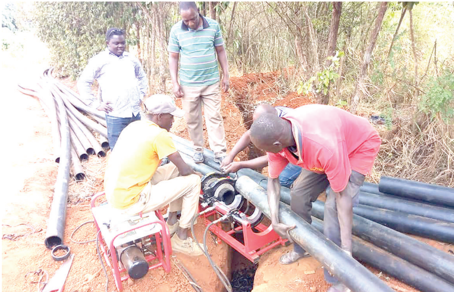
Shughuli za kutandika bomba kwenye mradi wa maji unaoendelea wilayani Handeni. Picha: MTANDAO.
