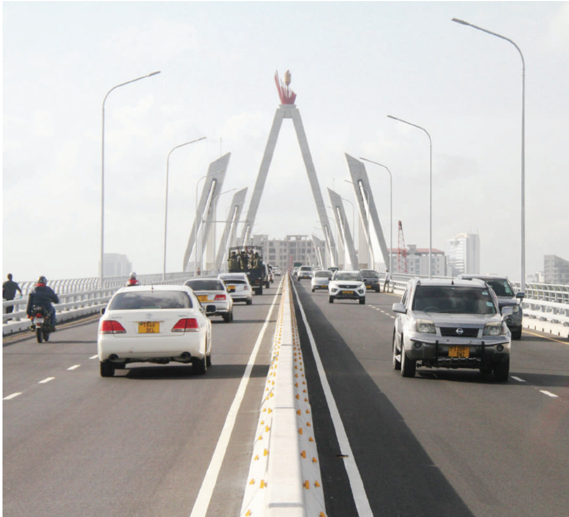
Magari yakipita katika Daraja la Tanzanite, baada ya kukamilika na kufunguliwa rasmi kwa matumizi, jijini Dar es Salaam jana. Habari Uk 19. PICHA: JUMANNE JUMA
