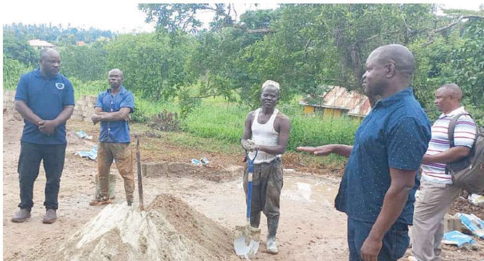
Mkurugenzi wa Halmashauri ya Wilaya ya Muheza, mkoa wa Tanga, Dk. Jumaa Mhina (kulia), akizungumza na mafundi wakati akikagua ujenzi wa madarasa mapya kati-ka shule mbalimbali wilayani humo jana, yanajengwa kwa fedha za mradi wa Boost. PICHA: STEVEN WILLIAM
