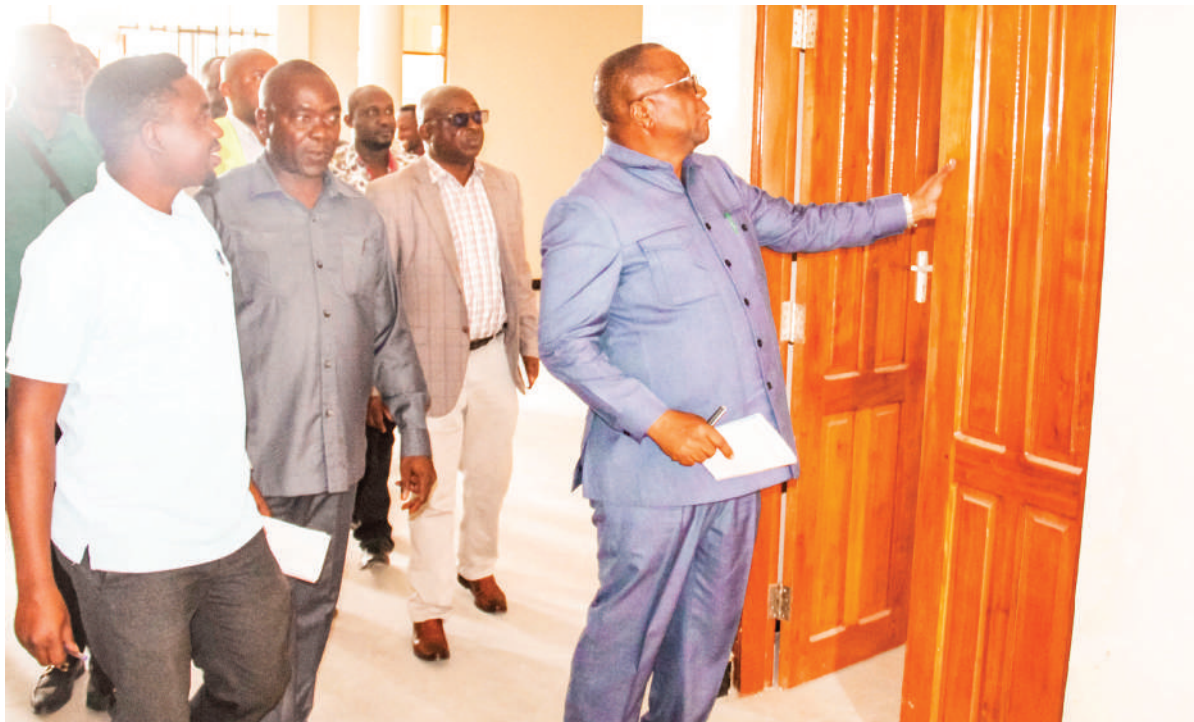
Mkuu wa Mkoa wa Shinyanga, Anamringi Macha (kulia), akikagua ujenzi wa ofisi mpya ya Mkuu wa Wilaya ya Kishapu, juzi na kubaini mapungufu kwenye uwekaji wa milango kuwa ipo chini ya kiwango. Ujenzi wa jengo hilo umefikia asilimia 95 na linatarajiwa kukamilika kujengwa June 30 mwaka huu kwa gharama ya Sh. bilioni 1.6.
