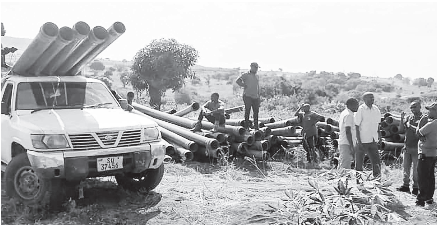
Mafundi wa Wakala wa Maji na Usafi wa Mazingira Vijijini (RUWASA), Mkoa wa Mara, wakishusha baadhi ya mabomba ili kuyatandaza katika vijiji vya Wilaya ya Musoma Vijijini, mapema wiki hii. PICHA: MPIGAPICHA WETU
