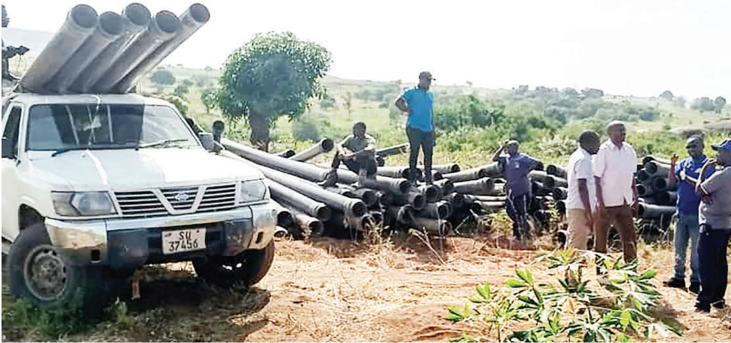
Mafundi wa Wakala wa Maji na Usafi wa Mazingira Vijijini (RUWASA), Mkoa wa Mara, wakishusha baadhi ya mabomba ili kuyatandaza katika vijiji vya Wilaya ya Musoma Vijijini, mapema wiki hii. PICHA: MPIGAPICHA WETU
