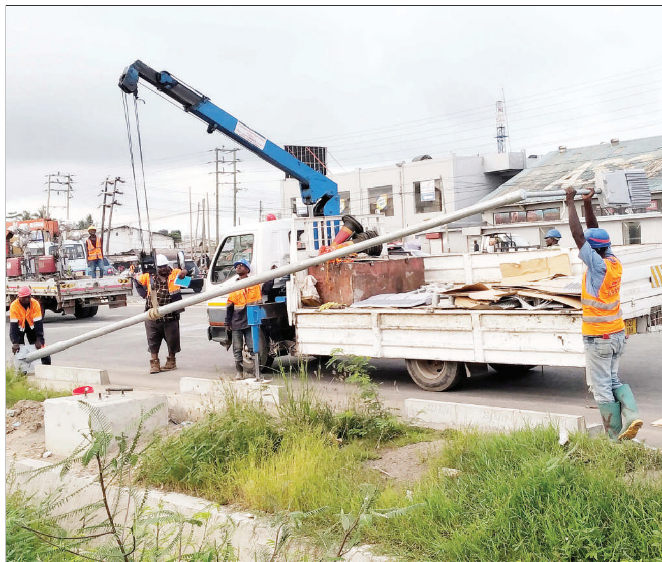
Mafundi wakiendelea na kazi ya kufunga nguzo za taa za barabarani zinazotumia nishati ya jua, katika Barabara ya Bagamoyo, eneo la kituo cha basi ITV Mwenge, jijini Dar es Salaam jana. PICHA: JOSEPH MWENDAPOLE
