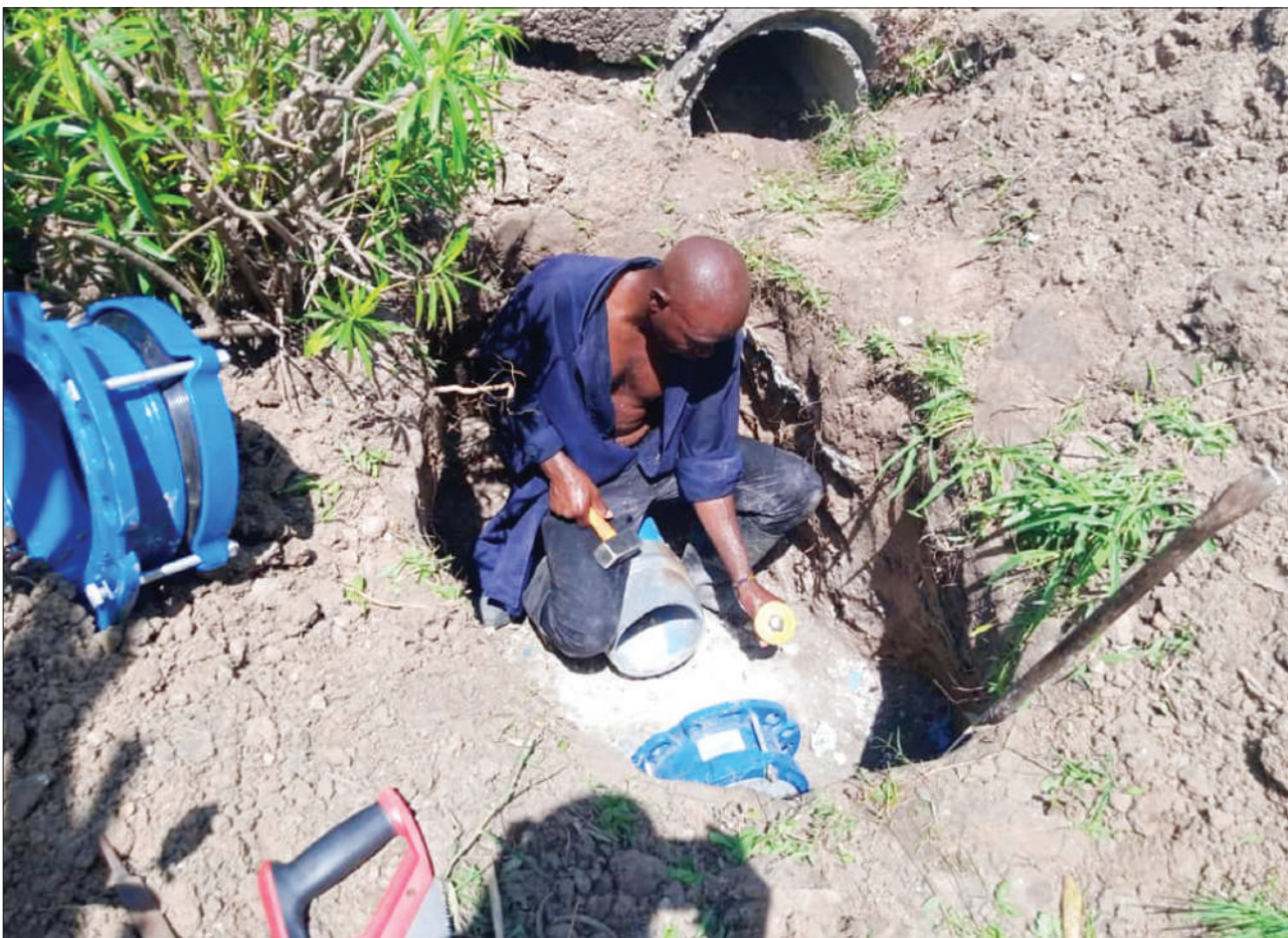
Fundi wa Mamlaka ya Majisafi na Usafi wa Mazingira Dar es Salaam (DAWASA), Vicent Attanasi, akibadilisha bomba la inchi nne na kuweka bomba la inchi nane kwenye eneo la Mlimani City, jijini humo jana, ili kuongeza wingi wa maji katika eneo hilo. PICHA: MPIGAPICHA WETU
