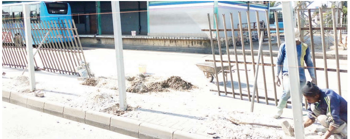
Mafundi wakikarabati uzio wa kituo cha mabasi ya mwendokasi cha Kimara Mwisho, Barabara ya Morogoro, Manispaa ya Ubungo Dar es Salaam jana, ambacho baadhi ya maeneo yameharibika kwa kugongwa na magari. PICHA: SABATO KASIKA
