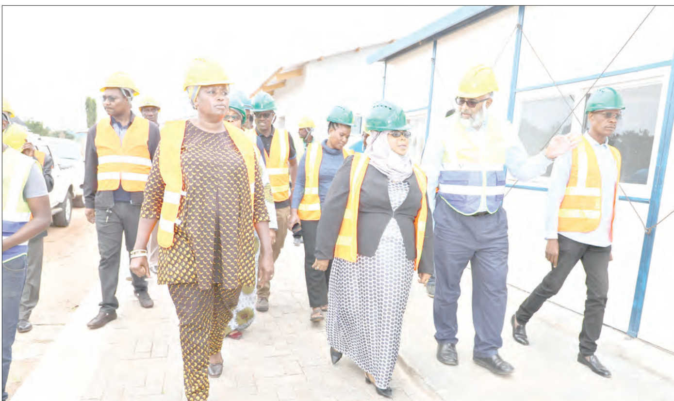
Mkandarasi wa ujenzi wa kituo cha mabasi Nyegezi, wilayani Nyamagana, mkoani Mwanza, Mhandisi Taher Jafferji (wa pili kulia), akimwongoza Naibu Waziri wa Fedha na Mipango, Mwanaidi Ali Khamis (wa tatu kulia), kukagua maendeleo ya ujenzi wa kituo hicho jana, ambacho hadi kukamilika kwake kitagarimu takribani Sh. bilioni 15.8. Kushoto ni Diwani wa Nyegezi, Edith Mudogo. PICHA: WFM
