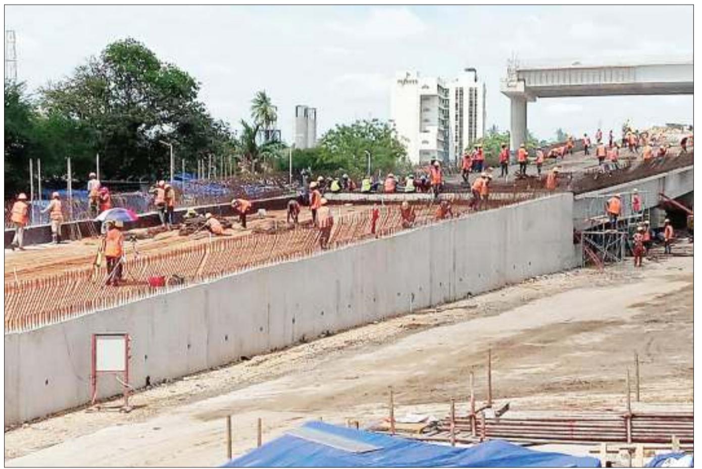
Mafundi wa wanaojenga barabara za juu za mpishano (Interchange) kwenye makutano ya Barabara ya Morogoro, Mandela na Sam Nujoma eneo la Ubungo, jijini Dar es Salaam, wakiendelea na hatua ya uwekaji lami kwenye barabara hizo, jana. Kwa mujibu wa Kampuni inayojenga ya China civil engineering construction cooperation (CCECC) ujenzi unatarajiwa kukamilika Desemba 2020. Picha: JOSEPH MWENDAPOLE
