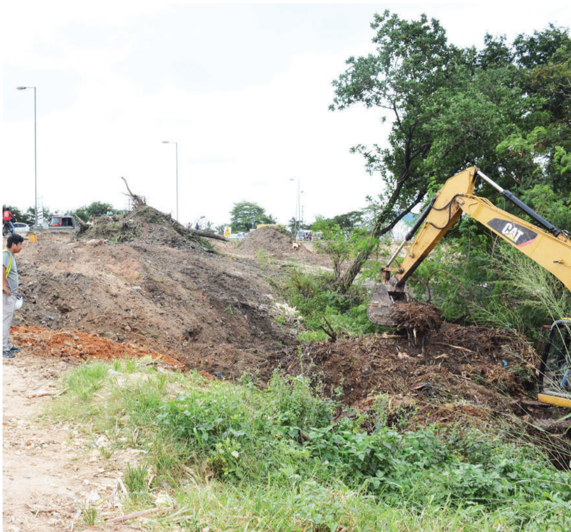
Awamu ya kwanza ya kusafisha ikiendelea ili kuanza ujenzi wa upanuzi wa barabara ya Morogoro kutoka Kimara Mwisho mpaka Ubungo, jijini Dar es Salaam jana. PICHA: MIRAJI MSALA
