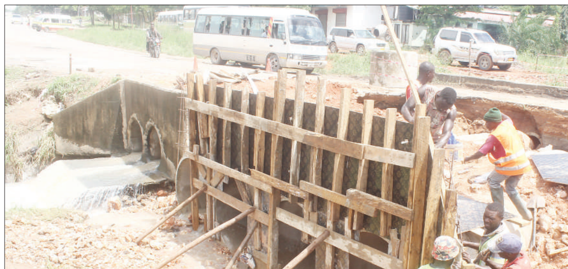
Mafundi wakien-delea na ujenzi wa daraja katika eneo la Pugu, jijini Dar es Salaam, jana. Picha: JUMANNE JUMA
