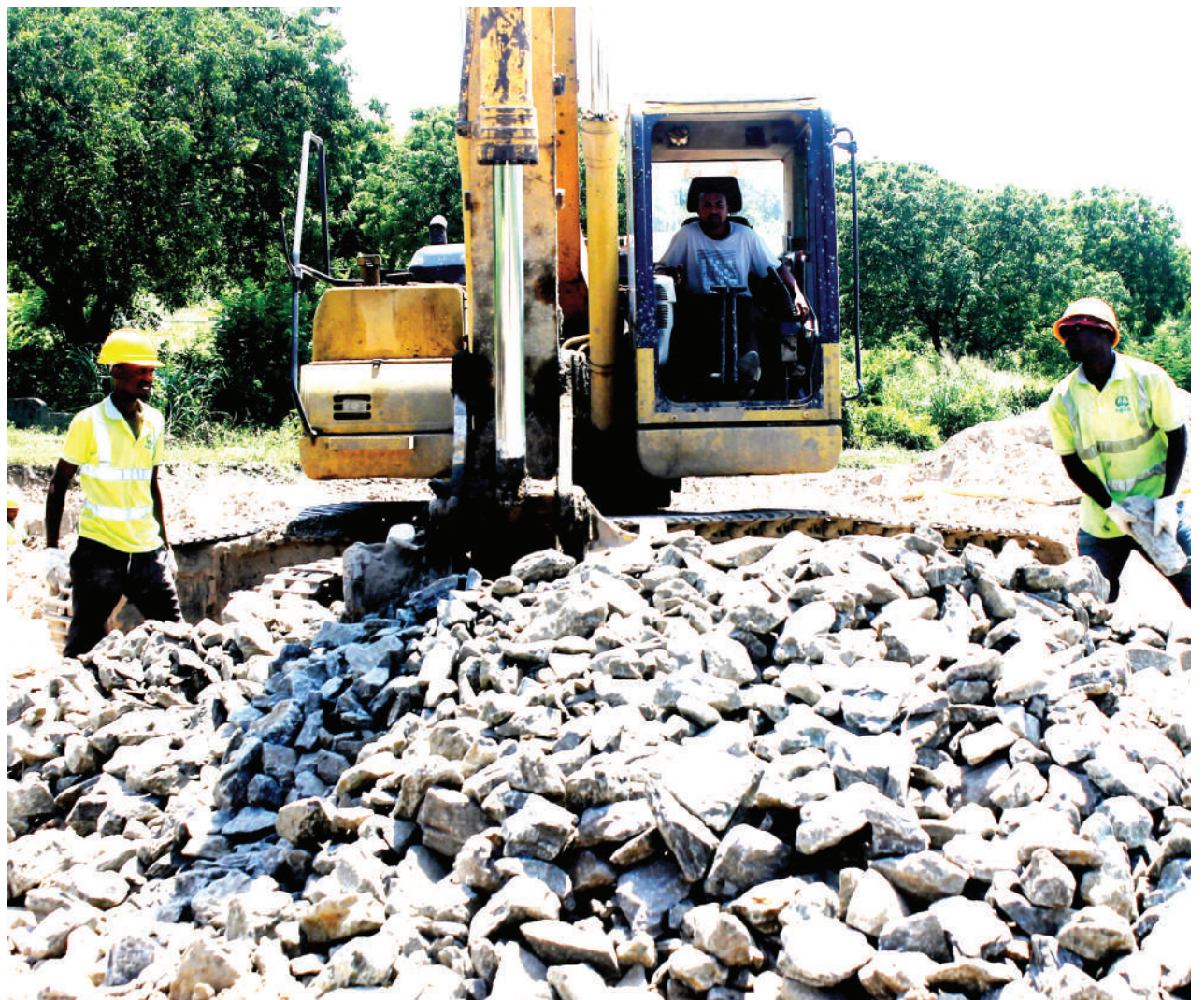
Mafundi ujenzi wakiandaa mawe kwa ajili ya kujenga ukingo wa maji ya bahari katika eneo la Kigamboni, jijini Dar es Salaam jana. Picha: JUMANNE JUMA
