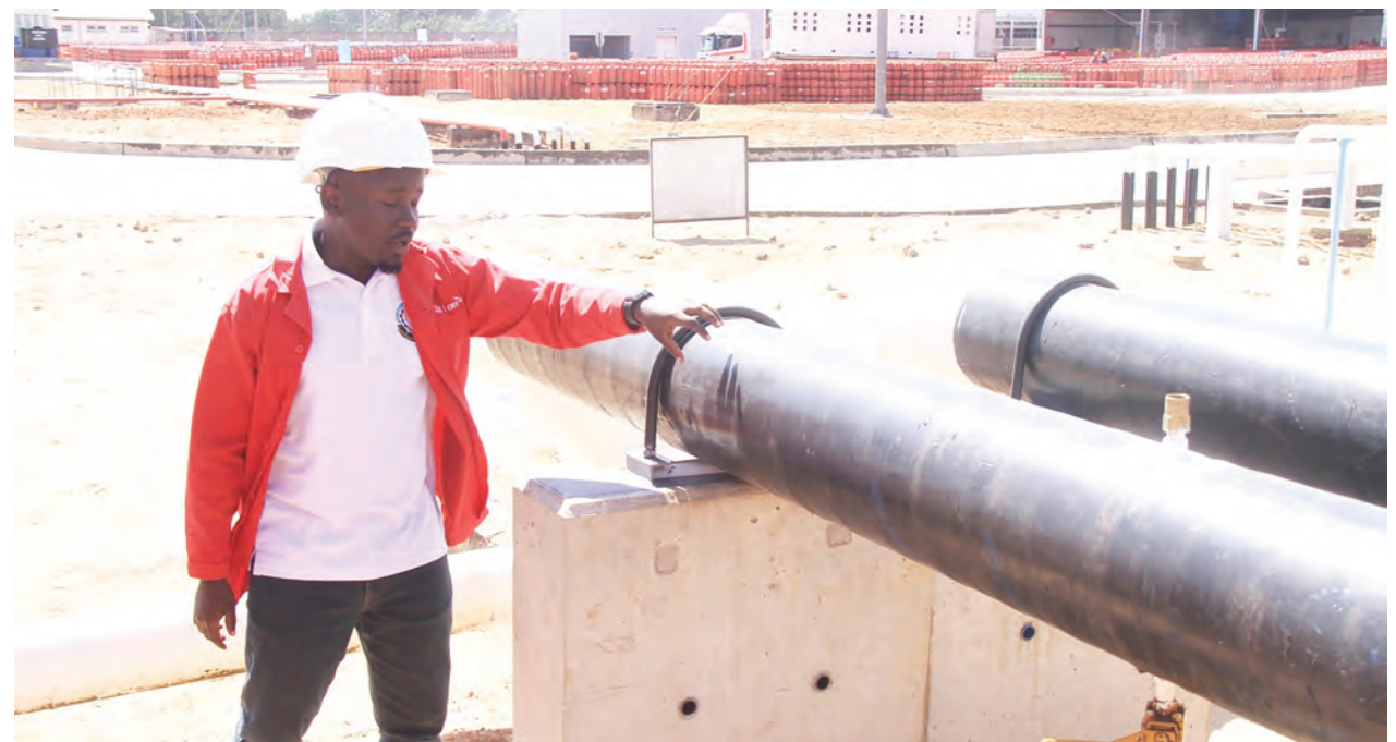
Meneja Mradi wa Kampuni ya Orxy, Joseph Soka, akionyesha bomba jipya la kupokea gesi la nchi 10, baada ya kukamilika kwa ujenzi wa mradi wa bomba hilo, litakaloongeza upatikanaji gesi kwa wateja wa kampuni hiyo Kigamboni, Dar es Salaam mwishoni mwa wiki. PICHA: MPIGAPICHA WETU
