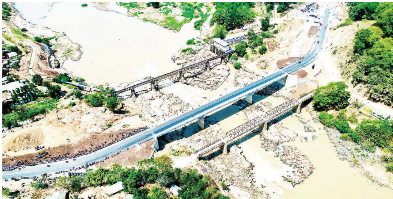
Mwonekano wa Daraja la Ruaha Mkuu lenye urefu wa mita 133 pamoja na barabara ya Kidatu -Ifakara yenye urefu wa kilomita 66.9 iliyokamilika kujengwa kwa kiwango cha lami ambayo imefunguliwa rasmi na Rais Samia Suluhu Hassan mkoani Morogoro juzi. PICHA: WIZARA YA UJENZI
