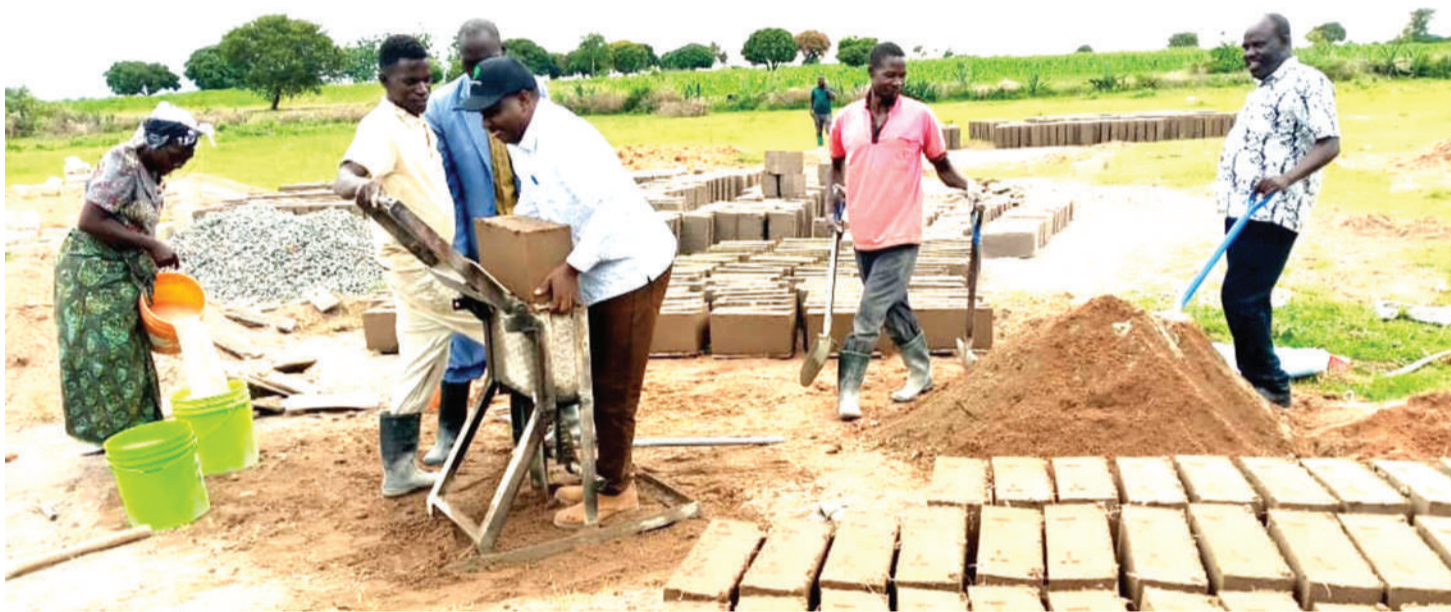
Mkuu wa Wilaya ya Musoma, Dk. Halfan Haule (mwenye kofia), akishiriki katika ufyatuzaji wa matofali ya ujenzi wa Shule ya Muhoji Sekondari.
