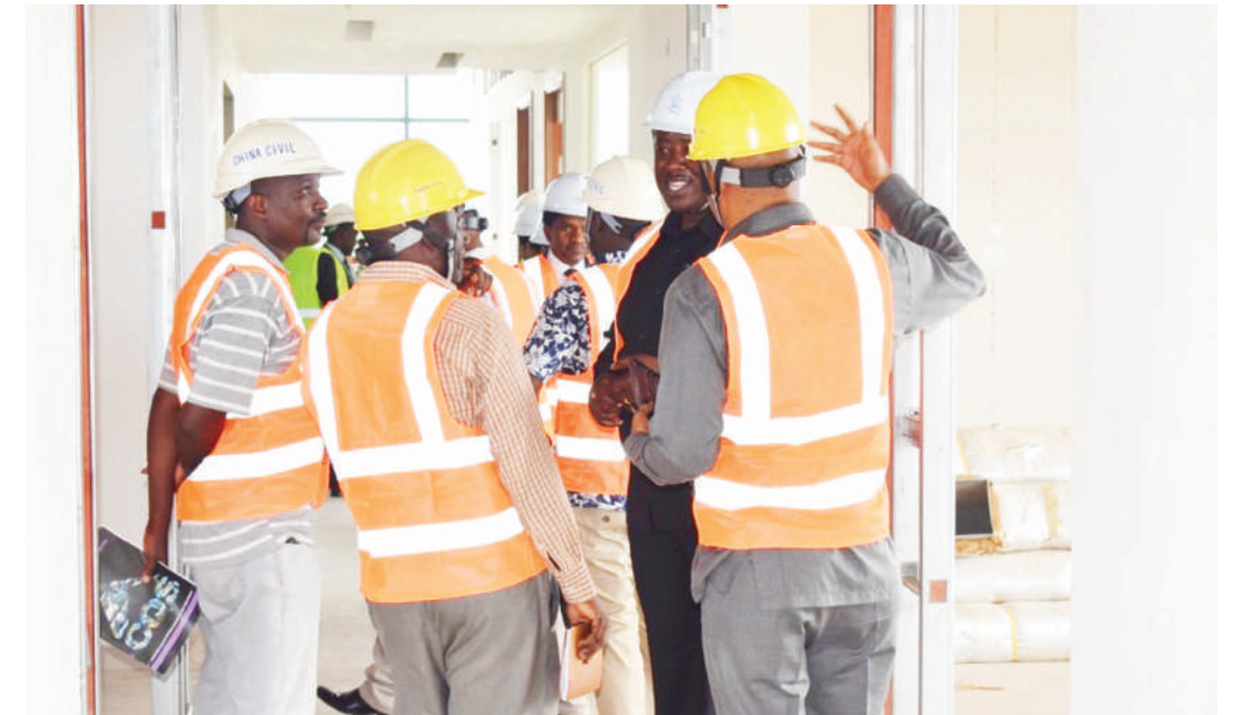
Ofisa Mtendaji Mkuu wa Dawasa, Mhandisi Cyprian Luhemeja, akitoa maelezo kwa Mwenyekiti wa Bodi ya Dawasa, Jenerali Mstaafu Davis Mwamunyange, akiwa na wajumbe wa bodi walipok- agua ujenzi wa jengo jipya la Dawasa, Ubungo, jijini Dar es Salaam juji. NA MPIGAPICHA WETU
