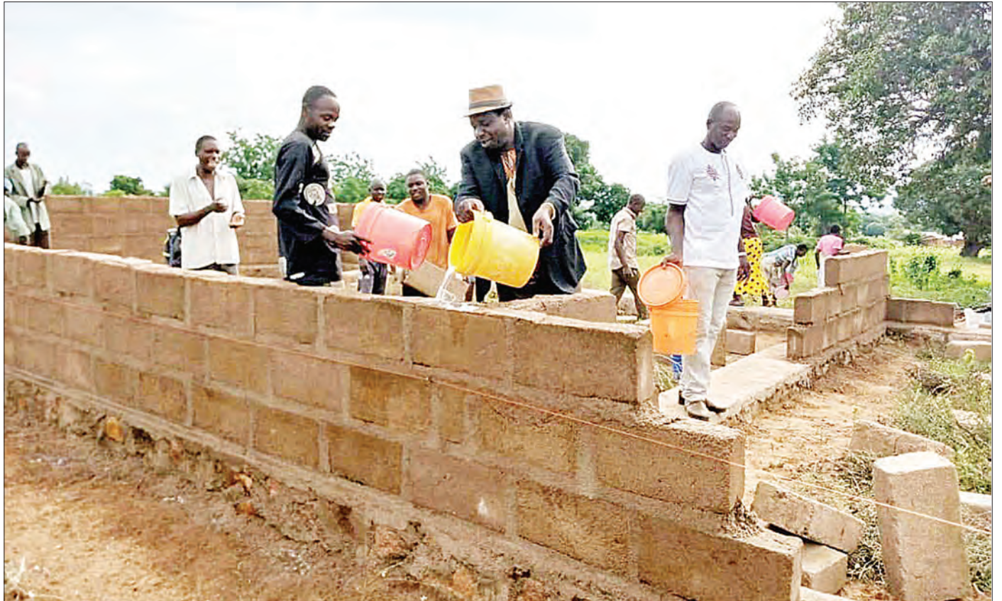
Diwani wa Kata ya Rusoli, Wilaya ya Musoma mkoani Mara, Boaz Nyeheura (mwenye kofia), akishirikiana na wakazi wa Kijiji cha Buanga kumwagilia ukuta wa darasa la shule ya awali (shikizi), ya kijiji hicho juzi, inayojengwa kupunguzia watoto kutembea umbali mrefu kufuata elimu. PICHA: MPIGAPICHA WETU
