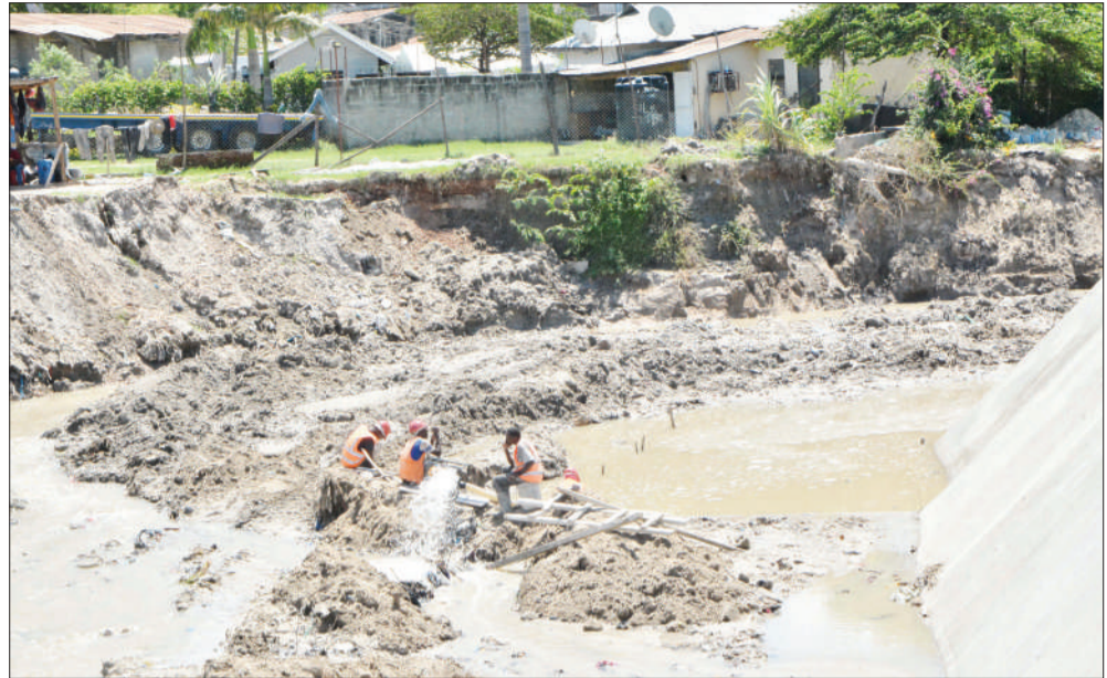
Mafundi wakitoa maji kwa ajili ya ujenzi unaoendelea wa kingo za Mto Ng'ombe, eneo la Sinza Shekilango, jijini Dar es Salaam jana. PICHA: MIRAJI MSALA
