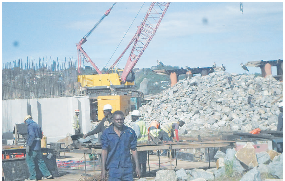
Ujenzi wa upanuzi wa Bandari ya Mwanza Kaskazini ukiendelea, mafundi wakiwa kazini.
