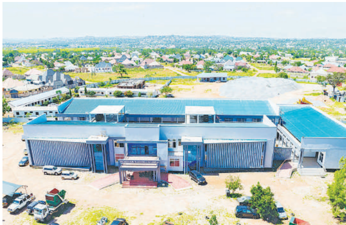
Jengo jipya la Utawala la Halmashauri ya Manispaa ya Ilemela
