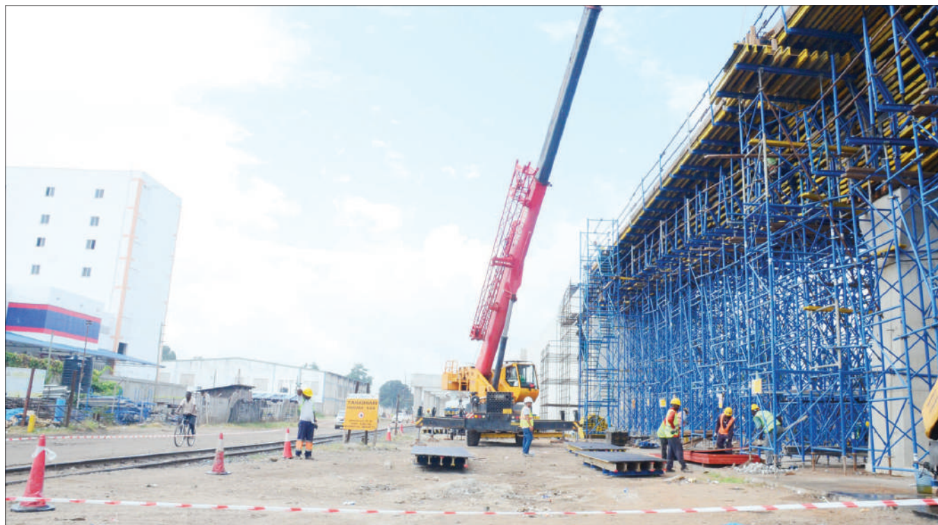
Mafundi wa kampuni ya ujenzi ya Yapi Markez, inayojenga reli ya umeme, wakiendelea na kazi Buguruni jijini Dar es Salaam, jana. PICHA: JUMANNE JUMA
