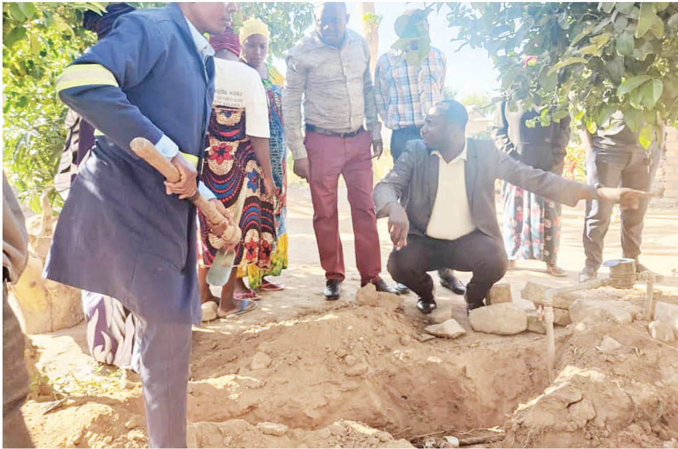
Ofisa Uhusiano wa Mamlaka ya Majisafi na Usafi wa Mazingira Mjini Kahama (KUWASA), John Mkama (aliye chuchumaa), akiwaonyesha wananchi wa Mtaa wa Mwime, Manispaa ya Kahama, namna Hamisi Omary mkazi wa mtaa huo alivyochepusha maji na kuingiza nyumbani kwake kinyume na taratibu. PICHA: SHABAN NJIA
