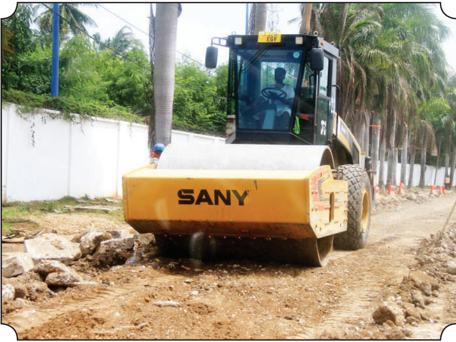
Mtambo wa ujenzi ukishindilia barabara ya muda kupisha ujenzi wa barabara ya mabasi ya mwendokasi jijini Dar es Salaam jana.
