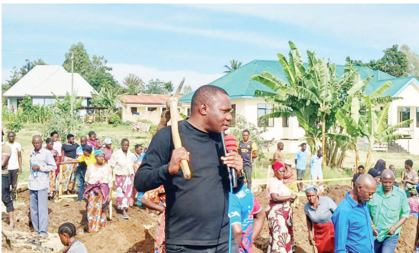
Mkuu wa Wilaya ya Musoma, mkoani Mara, Juma Chikoka akiwa na sururu yake alipokuwa akizungumza na wananchi wa Kijiji cha Kigera Etuma, kabla ya kushiriki kazi ya kuchimba msingi, kwa ajili ya ujenzi wa Shule ya Sekondari Kigera Mwiyaale, juzi. PICHA: MPIGAPICHA WETU
