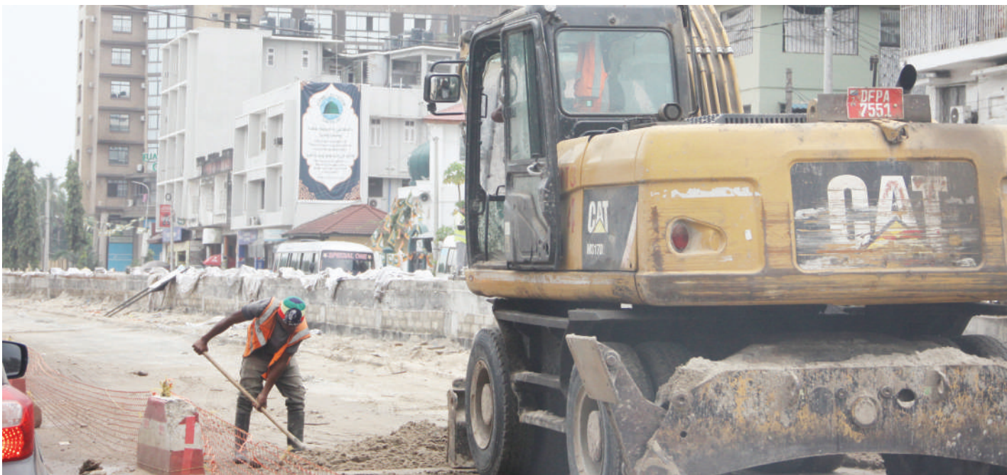
Fundi wa kampuni ya ujenzi ya Sinohydro, akiendelea na ujenzi wa barabara ya mabasi yaendayo haraka (BRT), katika barabara ya Bibi Titi Mohamed, jijini Dar es Salaam, jana. PICHA: JUMANNE JUMA
