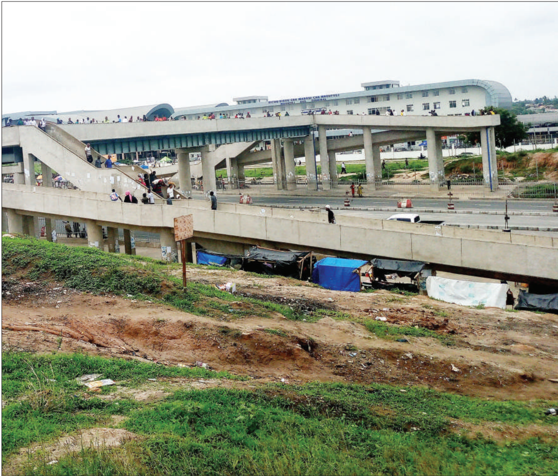
Mwonekano wa daraja la waenda kwa miguu lililoko Mbezi Luis Dar es Salaam, inadaiwa baadhi ya watu hawalitumii badala yake wanalazimisha kupenya katika uzio kuvuka upande wa pili wa Barabara ya Morogoro, kitendo ambacho ni hatari kwa usalama wao. PICHA: SABATO KASIKA
