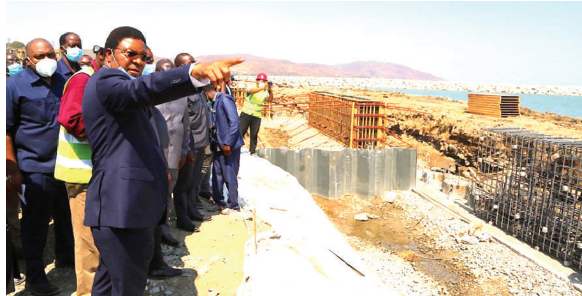
Waziri Mkuu Kassim Majaliwa, alipozulu kukagua ujenzi wa Bandari ya Karema, mkoani Katavi, mwaka uliopita.
