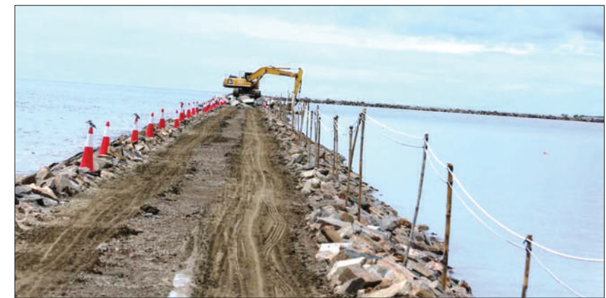
Kazi ya ujenzi wa Bandari ya Karema, ilivyokuwa inaendelea mwaka jana. Picha zote: Mtandao.
