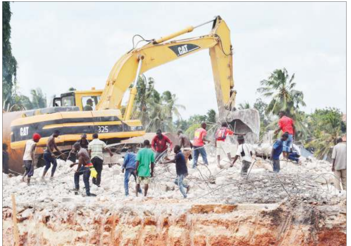
Wananchi wakitoa nondo baada ya kituo cha mafuta Mbezi Mwisho, Barabara ya Morogoro, kuvunjwa jijini Dar es Salaam jana, ili kupisha upanuzi wa barabara unaoendelea. PICHA: MIRAJI MSALA
