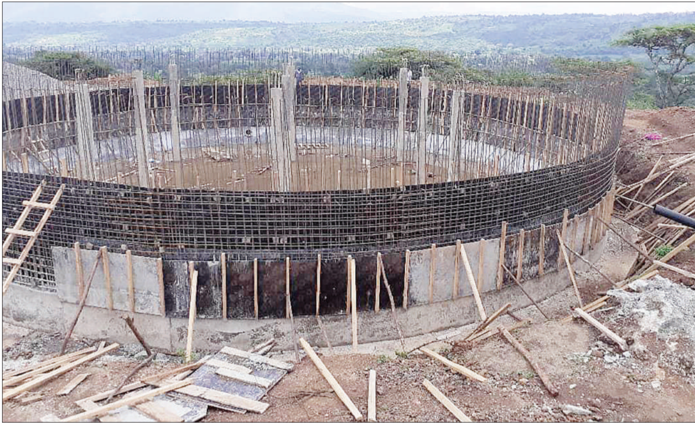
Ujenzi wa tanki la maji ukiwa unaendelea katika kijiji cha Izumbwe, kwajili ya kutekeleza mradi wa maji wa Shongo, ambao unatokana na agizo la Rais Dk. John Magufuli, wakati wa ziara yake mkoani Mbeya. PICHA: INNOCENT NG'OKO
