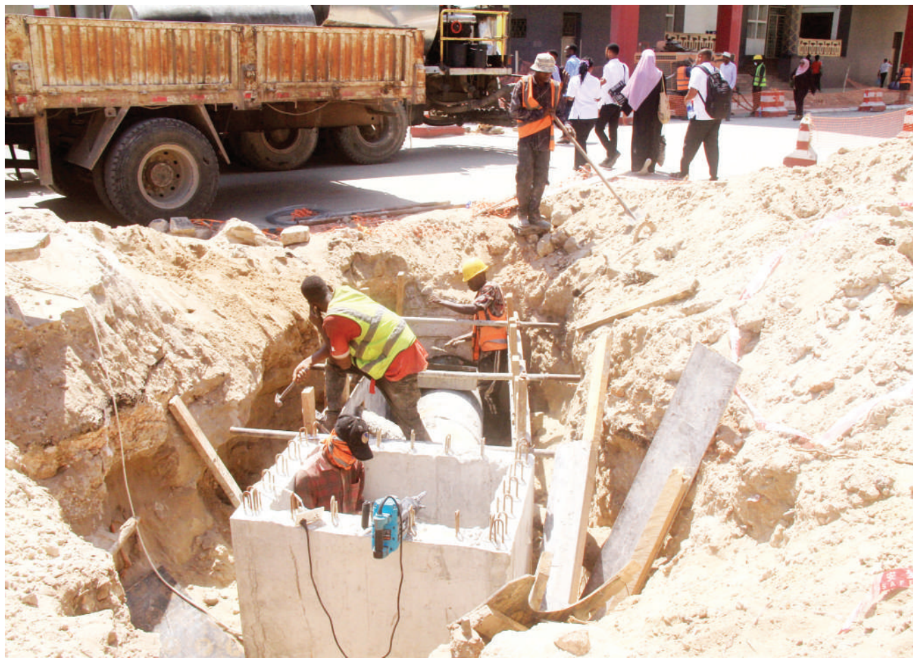
Wafanyakazi wa Kampuni ya Ujenzi ya Sinohydro wakijenga chemba ya maji ya mvua katika ujenzi unaoendelea wa barabara ya mabasi ya mwendo kasi Posta jijini Dar es Salaam jana. PICHA: JUMANNE JUMA
