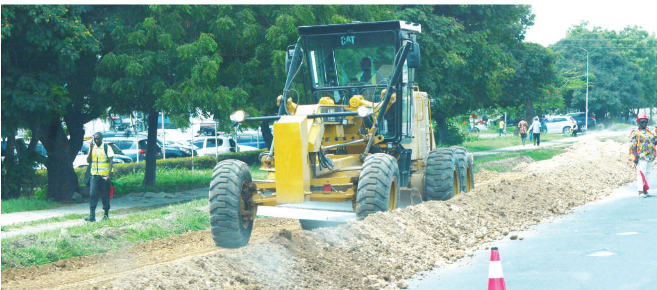
Ujenzi wa barabara ya mabasi yaendayo haraka (BRT III), ukiendelea katika barabara ya Nyerere, Banda la Ngozi, Dar es Salaam, jana. PICHA: JUMANNE JUMA
