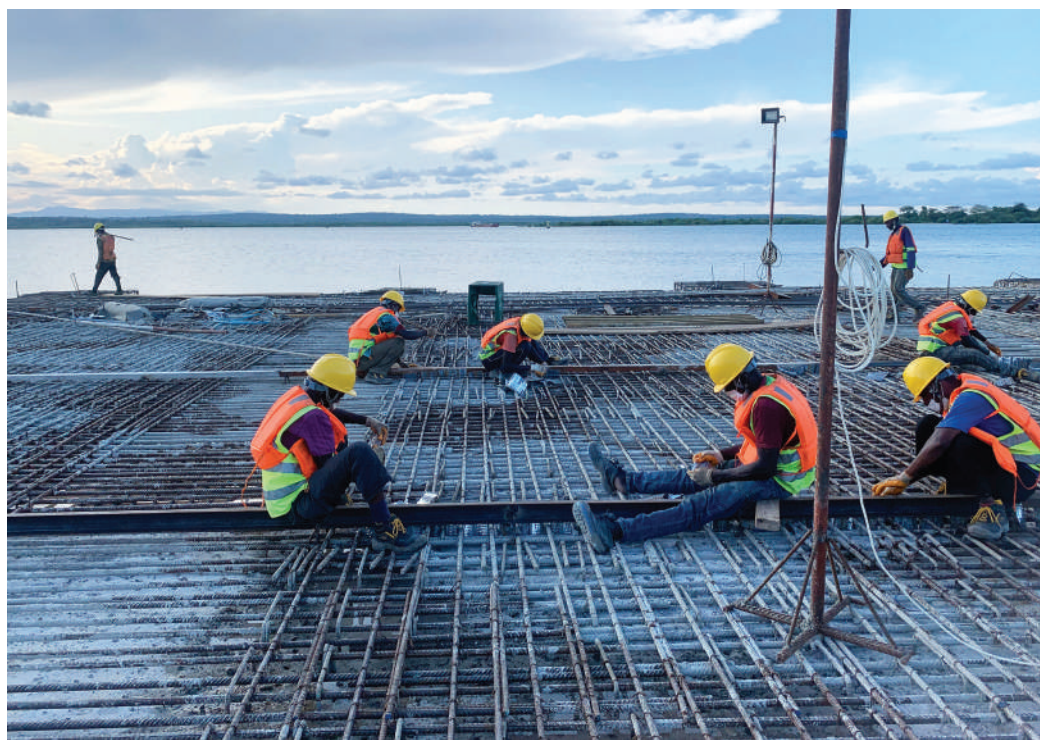
Mafundi wa kampuni ya ujenzi ya China Harbour Engineering wakiendelea na ujenzi wa awamu ya pili wa gati kwenye Bandari ya Tanga mwishoni mwa wiki. PICHA: MPI-GAPICHA WETU
