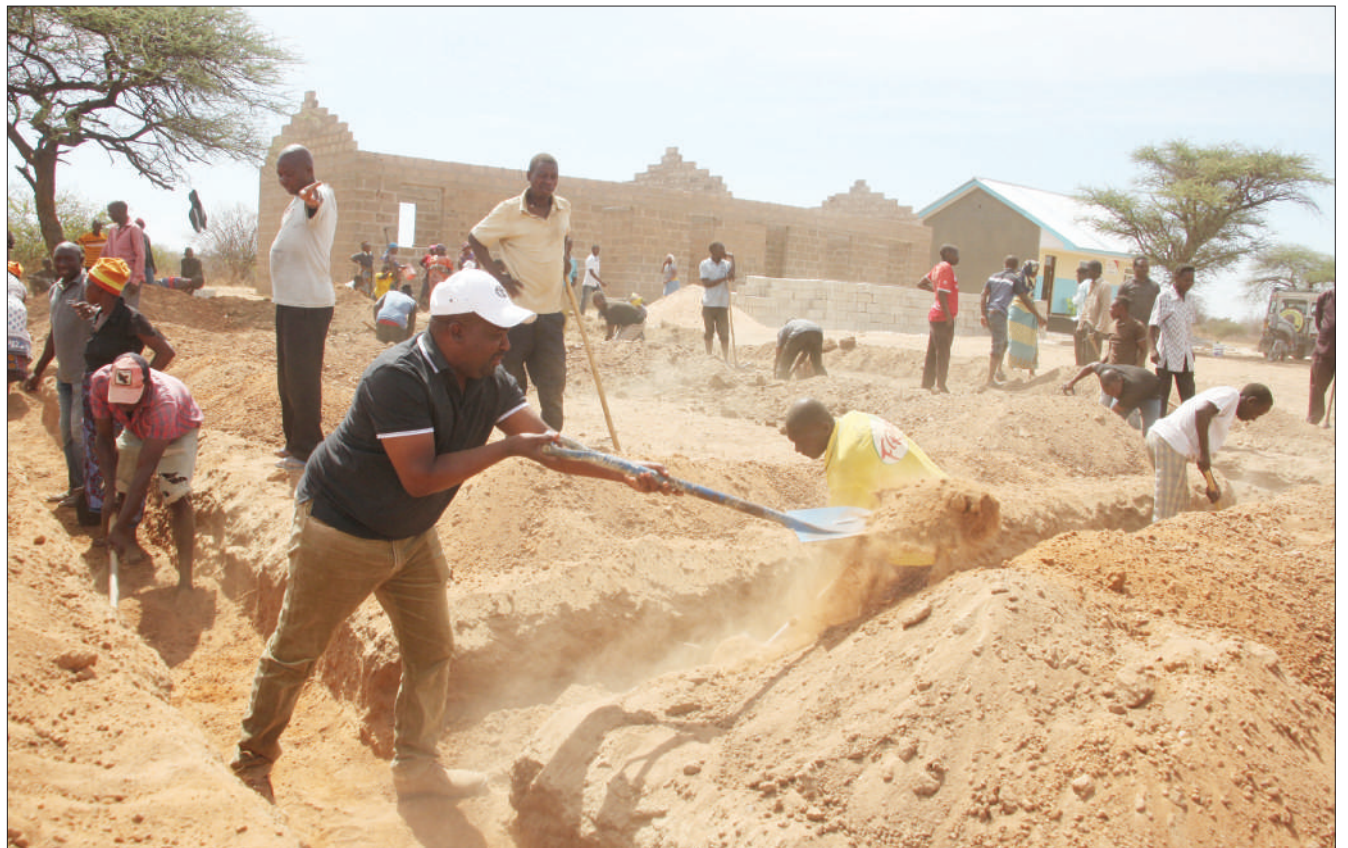
Mbunge wa Jimbo la Bahi, Kenneth Nollo (mwenye kofia), akishirikiana na wananchi wa Kijiji cha Msisi Juu kuchimba msingi wa ujenzi wa chumba cha ofisi ya kijiji hicho, Wilaya ya Bahi, mkoani Dodoma juzi. Katika ujenzi huo mbunge huyo amechangia mifuko 60 ya saruji, matofali 1,200 na fedha za kulipa mafundi. PICHA: IBRAHIM JOSEPH
