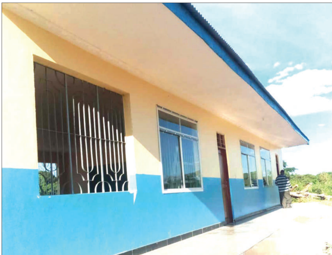
Moja ya majengo yaliyojengwa na wananchi kwa ajili ya VETA: MPIGAPICHA WETU
