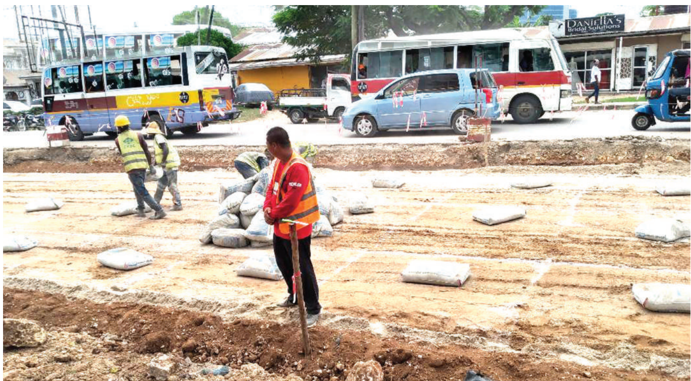
Mafundi ujenzi wakiweka saruji tayari kwa ajili ya kuweka lami katika barabara ya Sinza Shekilango, jijini Dar es Salaam juzi.
