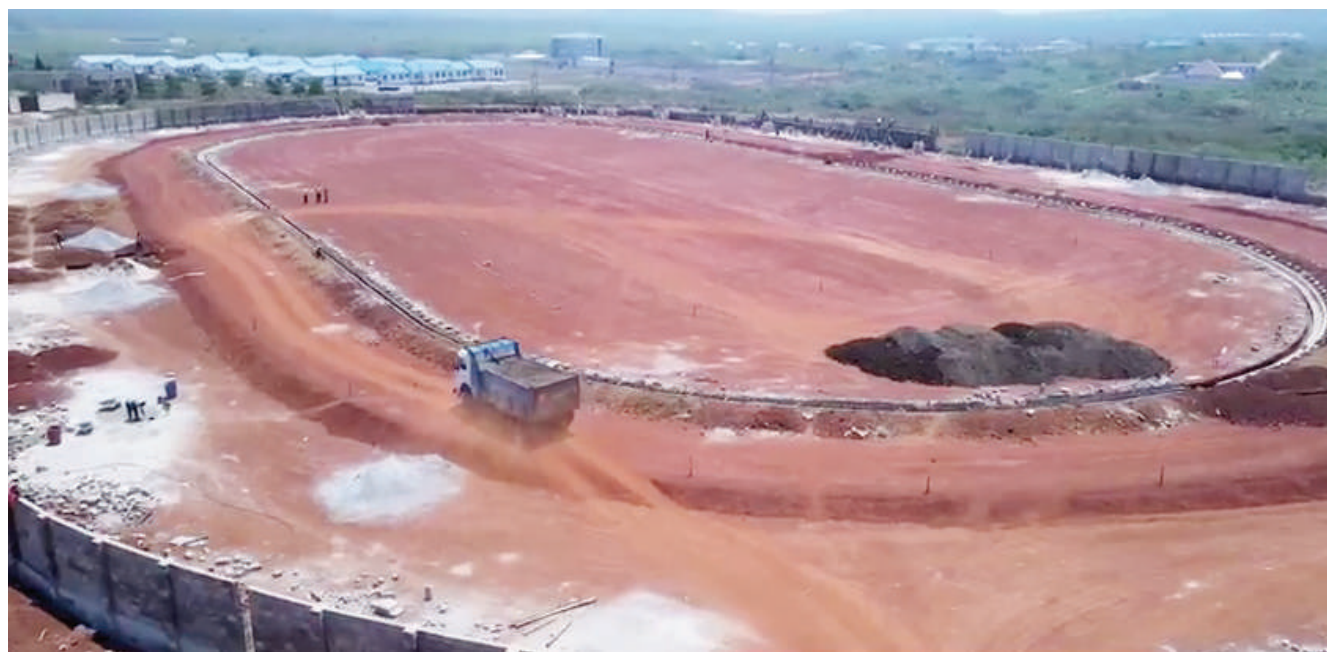
Ujenzi wa uwanja wa soka wa kisasa ukiendelea katika mtaa wa Magogo katika Halmashauri ya Mji wa Geita mkoani Geita kwa ufadhili wa Kampuni ya Geita Gold Mining Limited (GGML). NA MPIGAPICHA WETU
