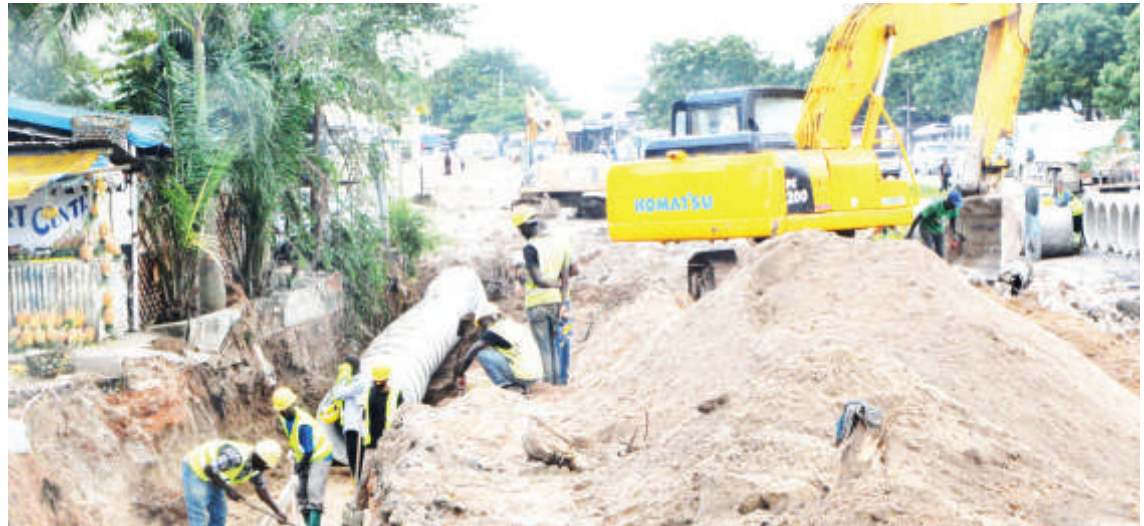
Mafundi wakienenda na kazi ya ujenzi wa mifereji ya maji ya mvua katika eneo la Magomeni, Manispaa ya Kinondoni, mkoani Dar es Salaam jana. Picha: MIRAJI MSALA
