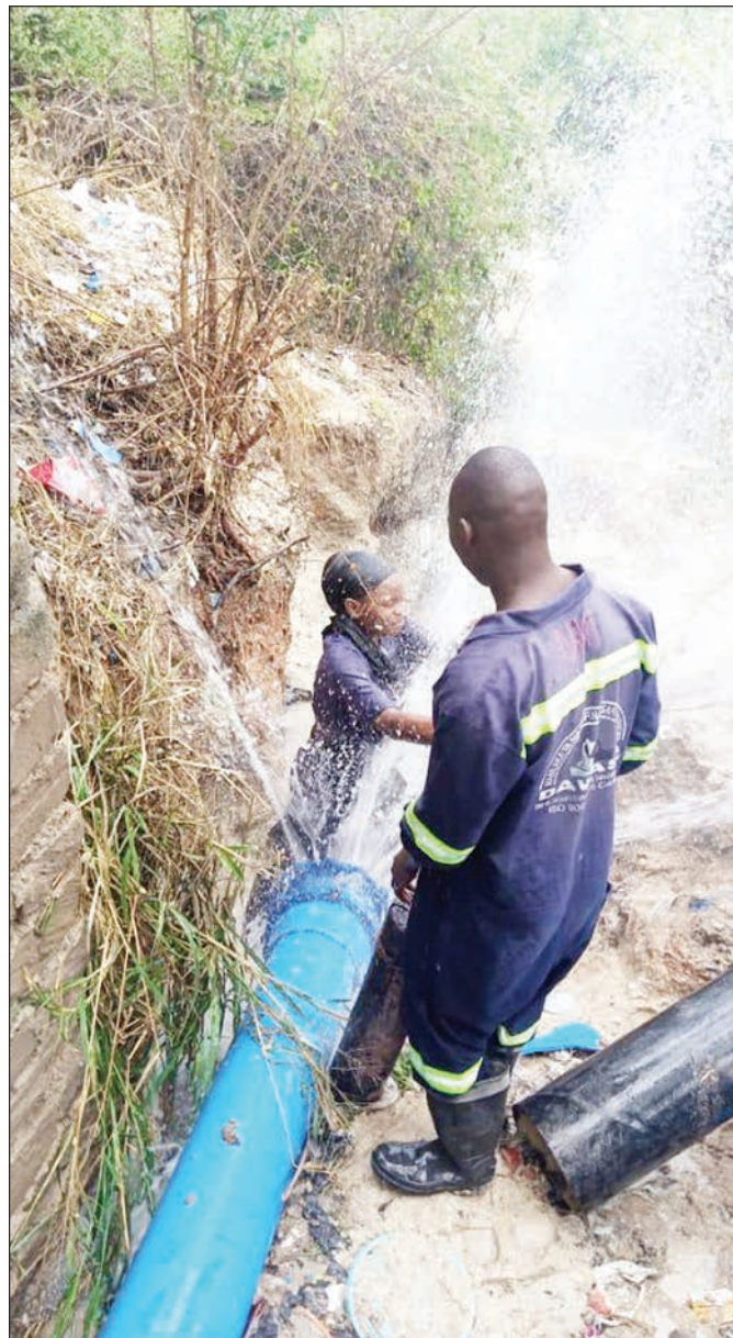
Mafundi wa Mamlaka ya Majisafi na Usafi wa Mazingira Dar es Salaam (DAWASA), wakidhibiti uvujaji wa maji katika bomba la inchi 10, eneo la Kimara, mkoani Dar es Salaam jana. PICHA: MPIOGAPI-CHA WETU
