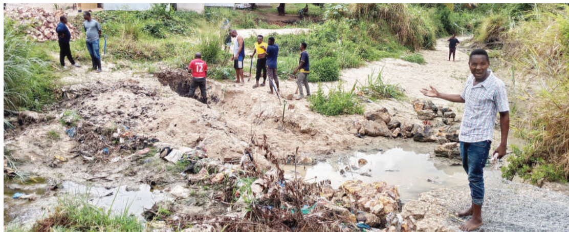
Mhamasishaji wa ujenzi wa daraja katika eneo la Kwa Nipe Malamba Mawili, Dar es Salaam, Jonas Kilamba (kulia), akielezea jinsi yeye na wakazi wenzake walivyochangis- hana fedha kwa ajili ya ujenzi huo walipokuwa wa- kichimba msingi jana. PICHA: SA- BATO KASIKA
